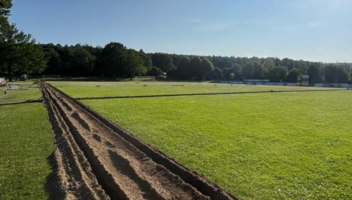
In diesen Gräben liegt nun unsere neue Beregnungsanlage
